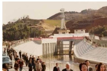
日下川放水路完成 (S57.2)
