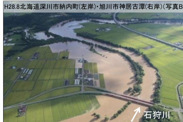
平成28年8月出水の状況
