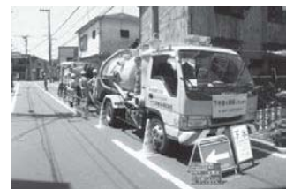
吸引車による下水道管の清掃
