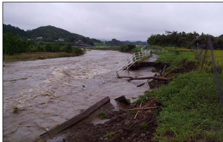
一級河川九十九川の出水状況（群馬県安中市）
