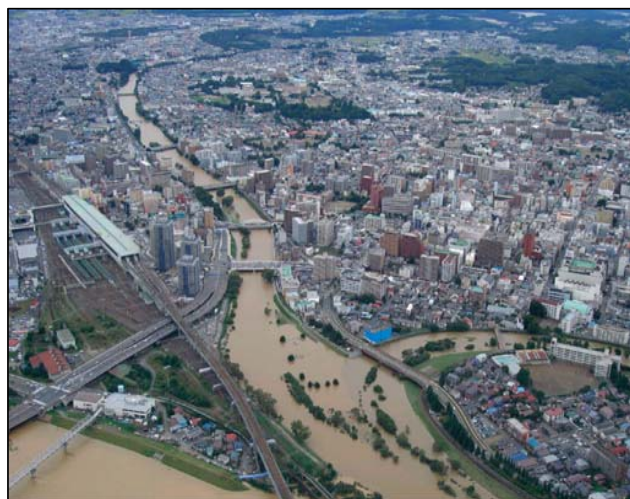
一級河川北上川の出水状況 (岩手県盛岡市)
