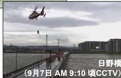
日野橋 (9月7日 AM 9:10 頃CCTV) 一級水系多摩川の出水状況 (東京都日野市、神奈川県川崎市)
