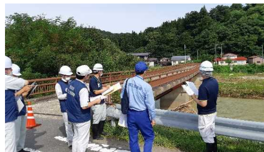
緊急調査状況(開晴橋(町道山子線))
