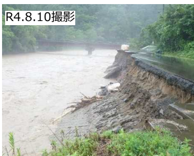
二級河川追良瀬川(町道松原1号線)
