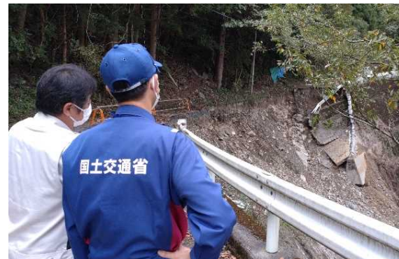
緊急調査状況 (町道 山瀬橋・長崎線)
