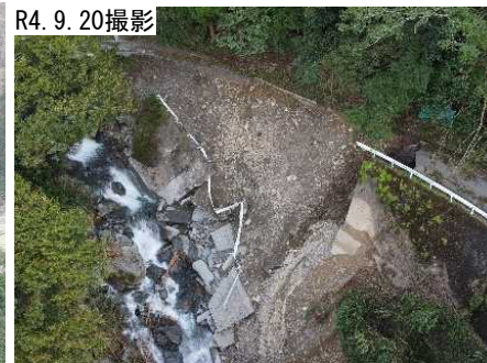
町道 山瀬橋・長崎線 (美郷町)
