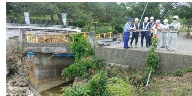
緊急調査状況(公園2号橋(町道上六角平谷地線))
