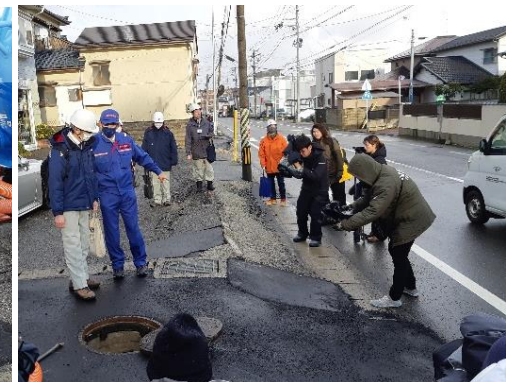
緊急調査状況 (新潟亀田内野線・西区寺尾)
