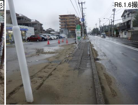
(主)新潟亀田内野線・西区青山1丁目(道路)
