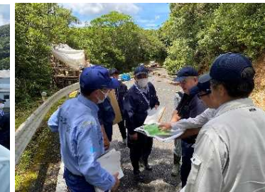
緊急調査状況(名瀬瀬戸内線)
