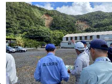
緊急調査状況(湯湾大棚線)
