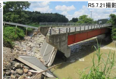
主要地方道 秋田岩見船岡線 新川橋(秋田市)
