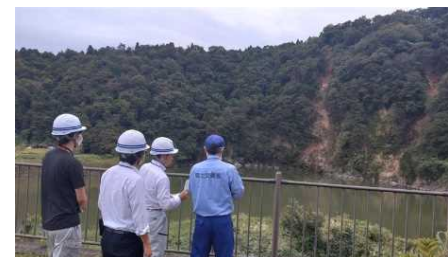
緊急調査状況(十王ダム)
