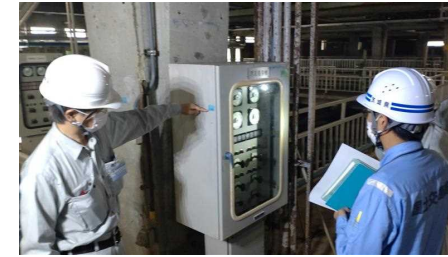
緊急調査状況(池の川処理場)
