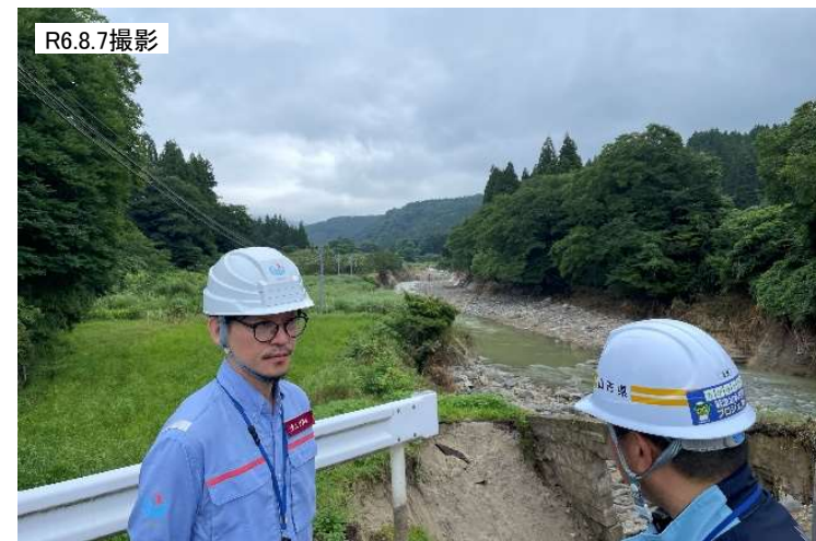
緊急調査状況(市道六助草田線六助橋)
