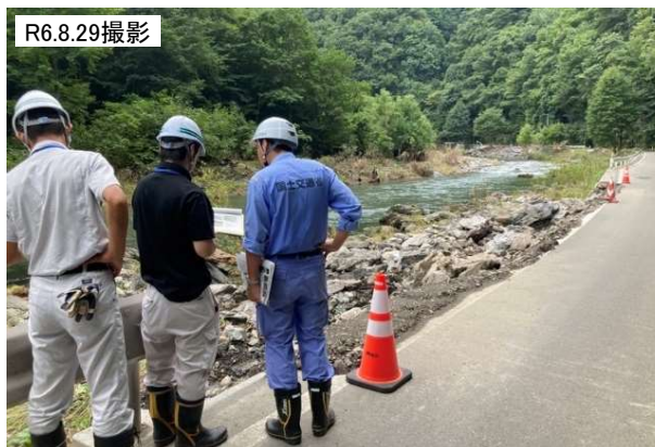
緊急調査状況(普代小屋瀬線 半城子) 【助言】 ・前後施設に合わせた復旧で問題ないと考える。
