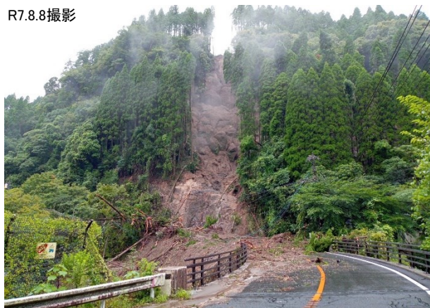
国道223号 霧島市牧園町宿久保田地内 被災状況
