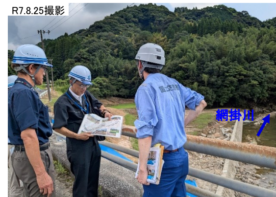
緊急調査状況(二級河川 網掛川(小山田)) 【助言】 ・護岸については、背面洗掘の状況も踏まえて詳細調査を実施し、被災について整理すること。 ・被災水位、河床低下等調査も踏まえ工法検討すること。
