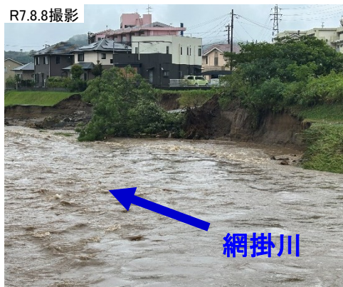
二級河川 網掛川 被災状況
