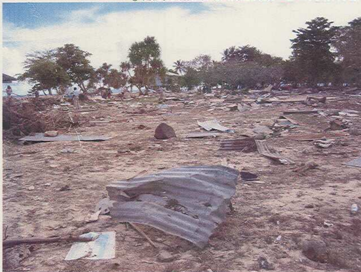
④津波によって村のほとんどの家屋が流失 ティティアナ村(ギゾ島)
