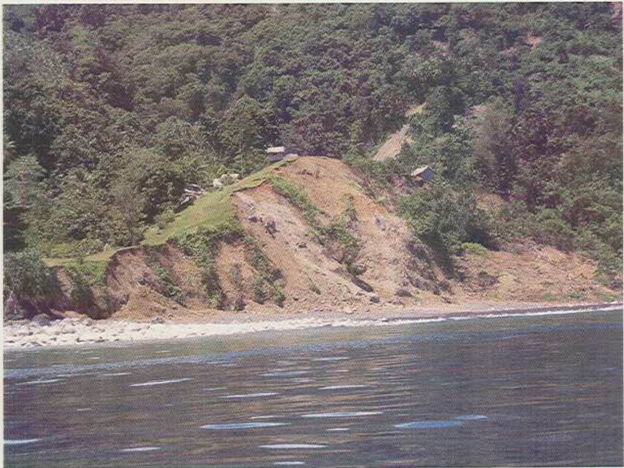
⑧地震により、斜面が崩壊 モンド村(ラノンガ島)
