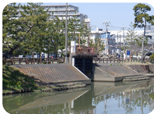
2022 年（令和 4 年 3 月）頃 写真提供：江戸川河川事務所
