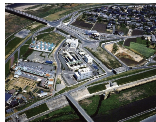
高屋川河川浄化施設
