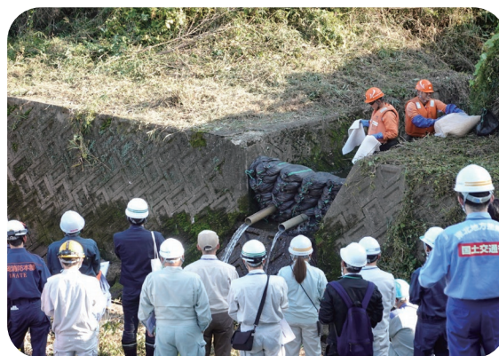
土のうによる下流拡散防止工の実演
