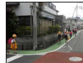
路肩のカラー舗装
