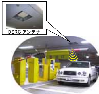
図 ETCを用いた駐車場入退出管理
