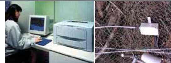
図 落石検知システム(大規模崩落のモニタリング)
