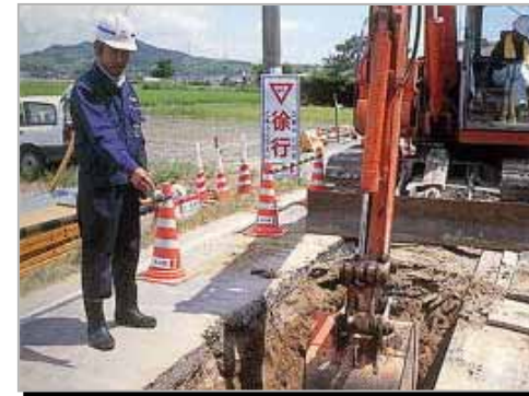
図 路上工事の効率化
