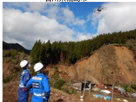
ドローンによる被災状況調査
