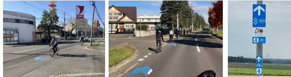
路面表示(矢羽根)による安全対策
