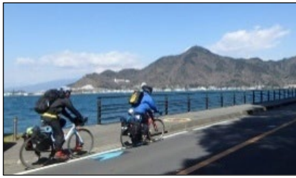
路面表示（矢羽根）の設置
