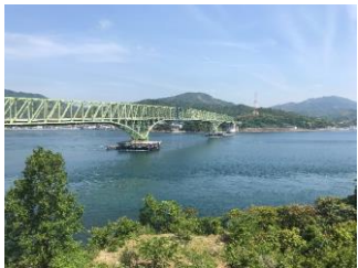
大島瀬戸（大島大橋）
