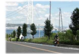
明石海峡大橋
