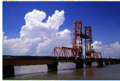
【筑後川昇開橋】
