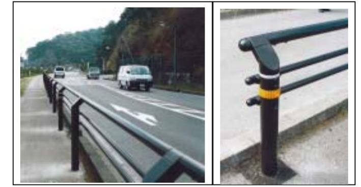
写真2 防護柵そのものの形を洗練させた例
