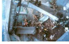
マイアス橋の崩壊（1983年）
