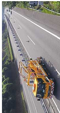
<規制機材の自動設置状況>
