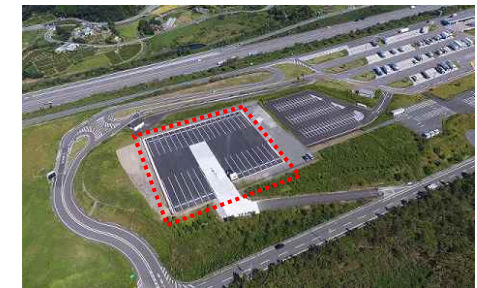
<浜松SAに隣接して整備された物流中継拠点（コネクティア浜松）>
