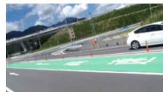
高速道路出入口部における対策 (カラー舗装)
