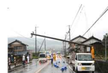
沿道の電柱の倒壊による道路閉塞
