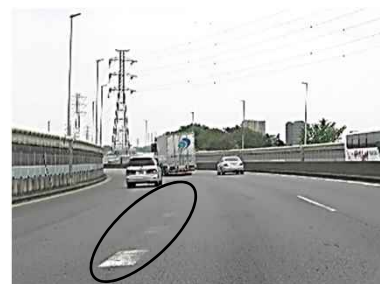
▲白線かすれ事例 (車載センサによる自己位置特定に必要な区画線等のあり方を検討)
