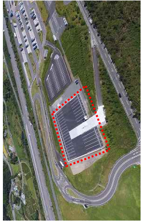
<浜松SAIに隣接して整備された物流中継拠点(コネクトエリア浜松)>
