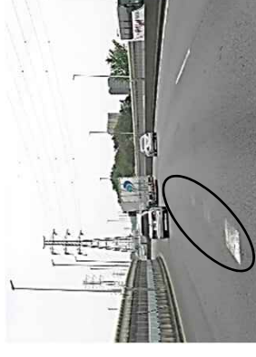
白線かすれ事例 (車載センサーによる自己位置特定に必要な区画線等のあり方を検討)
