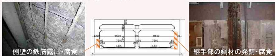
側壁の鉄筋露出・腐食
