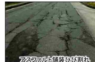
アスファルト舗装ひび割れ
