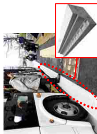
〔隙間を空けずに停留所に停車可能な縁石〕
