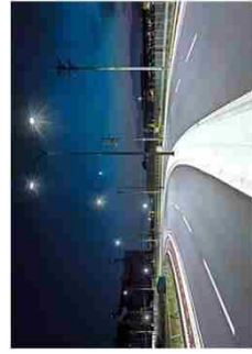
LED照明による省エネ効果 消費電力約6割削減 (高圧ナトリウム灯比) 出典：令和3年度 道路分科会 基本政策部会 資料
