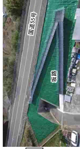
想定浸水深よりも高い歩道部への坂路を整備 (国道55号 高知県安芸郡奈半利町)
