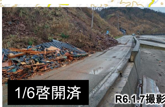
崩落箇所 啓開完了
