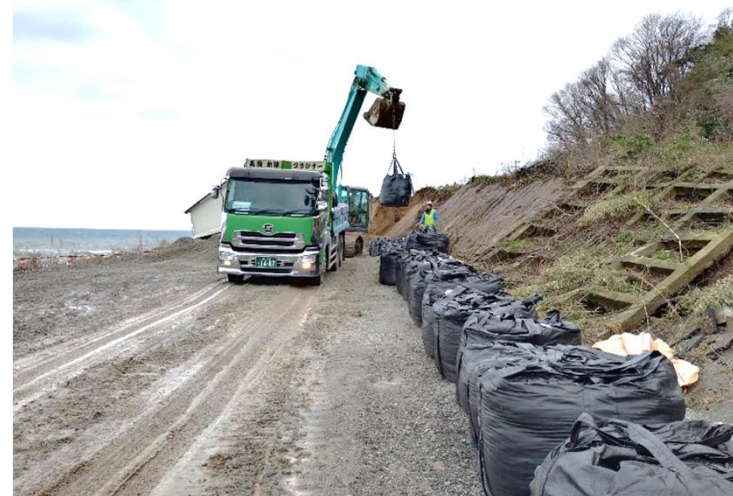
R249輪島市稲船町付近 大型土嚢設置・崩落土砂撤去作業
