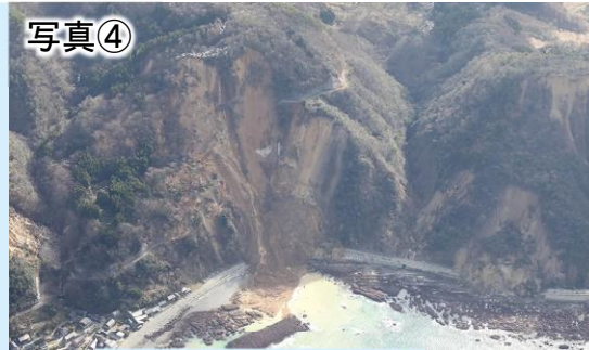
国道249号法面崩落
