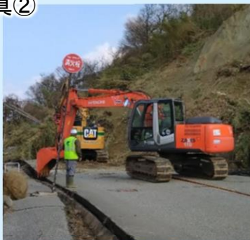
国道249号作業状況
