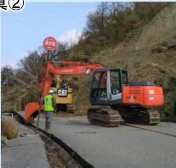
国道249号作業状況
