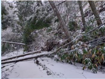
県道38号被害状況
