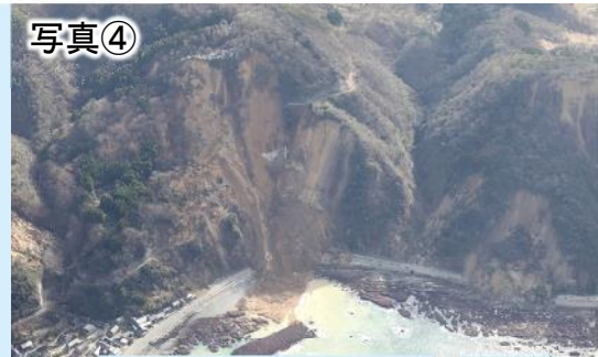
国道249号法面崩落
