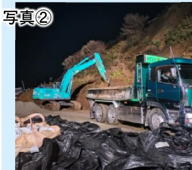
国道249号作業状況
