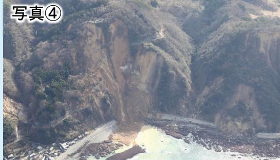
国道249号法面崩落
