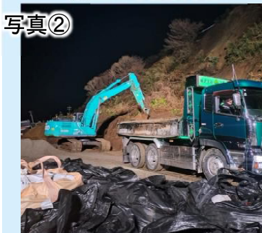
国道249号作業状況
