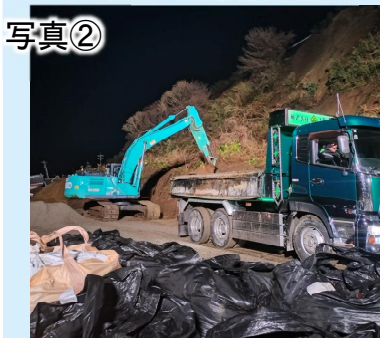
国道249号作業状況
