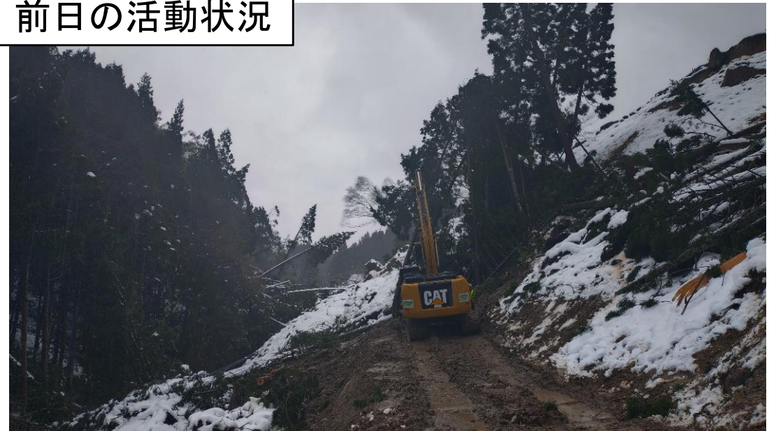
R249輪島市門前町浦上付近 倒木除去作業
