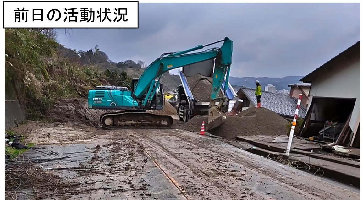
R249輪島市稲船町付近 砕石敷均作業
