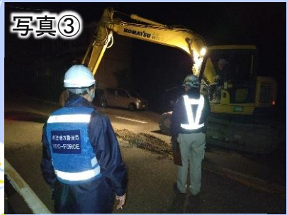
国道249号啓開作業
