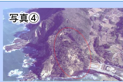
国道249号トンネル坑口崩落
