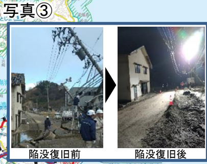
陥没復旧前 陥没復旧後 国道249号緊急復旧完了
