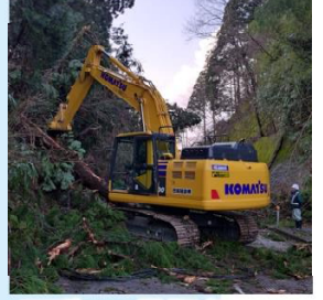
国道249号緊急復旧
