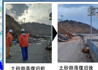
土砂崩落復旧前 土砂崩落復旧後
