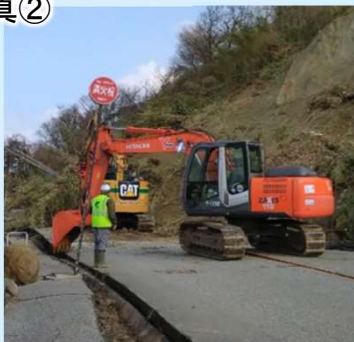
国道249号作業状況
