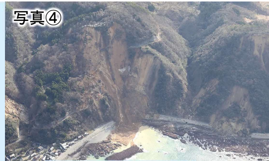
国道249号法面崩落
