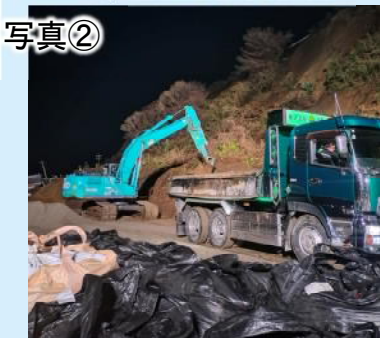
国道249号作業状況
