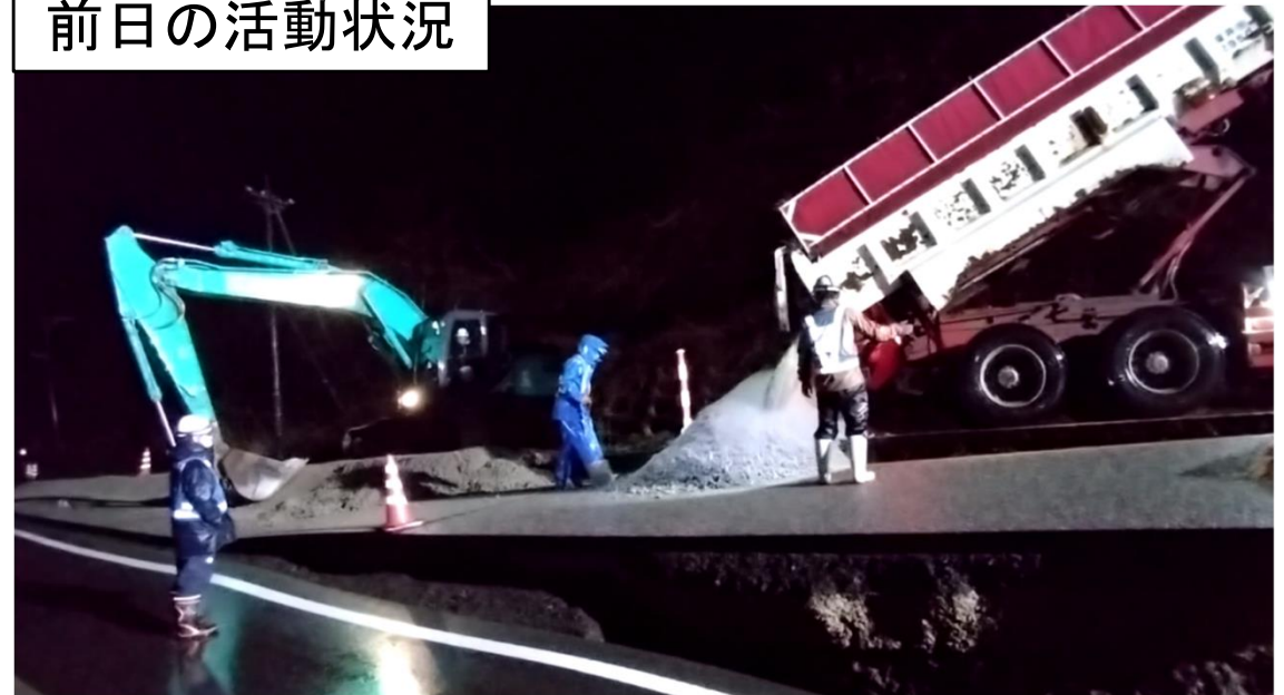
R249輪島市深見町付近 砕石敷均し作業
