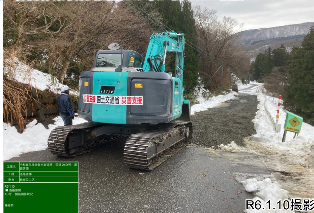
啓開作業状況(国道249号から6.2km地点)
