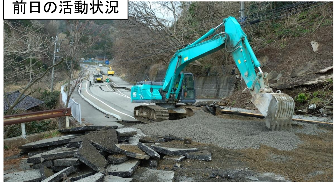
R249輪島市深見町付近 碎石敷均し作業
