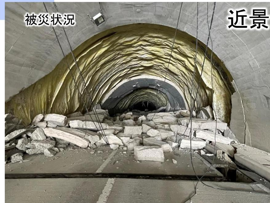
● 珠洲市若山町出田地内「すずなり西口交差点」から8.6km地点 トンネル覆工崩落箇所
