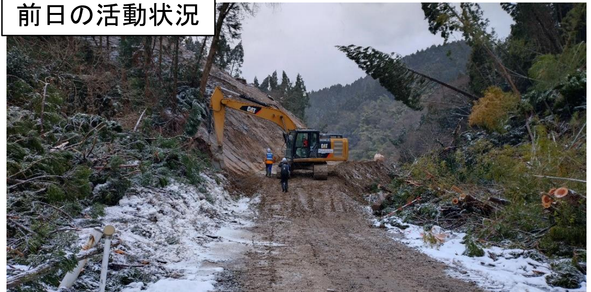
R249輪島市門前町浦上付近 道路造成作業
