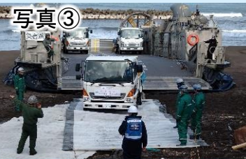
深見海岸への資機材陸揚げ
