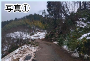
県道38号緊急復旧完了状況
