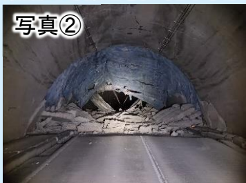
国道249号中屋トンネル崩落状況
