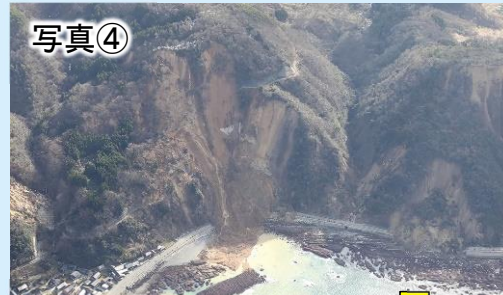
国道249号法面崩落状況
