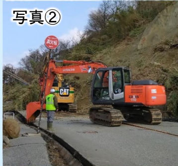
国道249号緊急復旧作業状況
